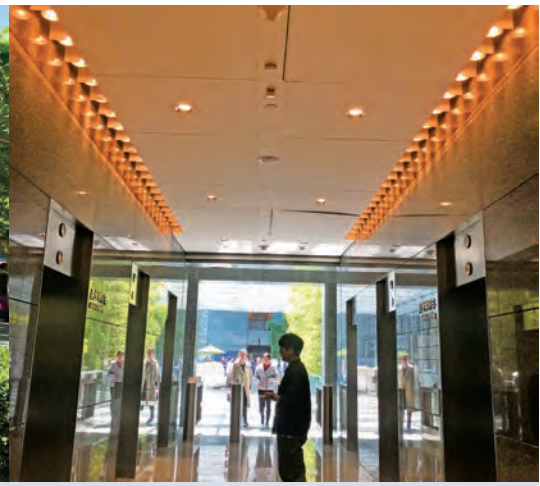
照明光源更換成節能LED光源
