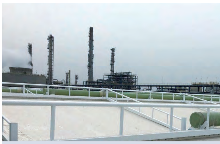
污水處理裝置
